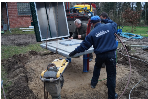
Ny råvandstation sættes på plads
